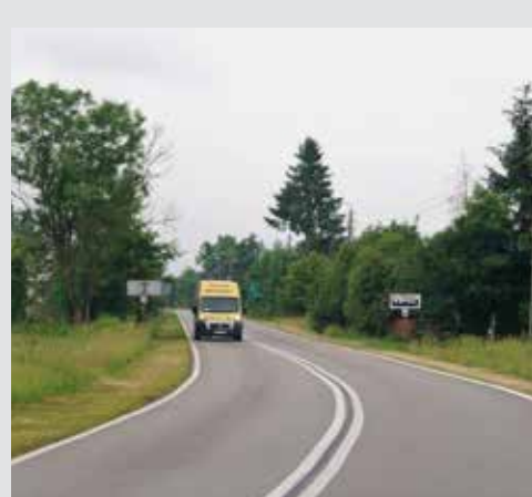
Rozbudowa DP 4328W w miejscowości Sulejów, gmina Jadów. Koszt 1 252 574 zł.
