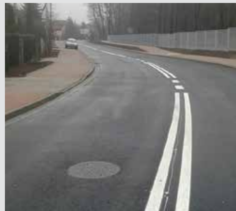
Przebudowa ciągu ulic Kochanowskiego - Drewnickiej w Ząbkach. Koszt 5 383 681 zł.
