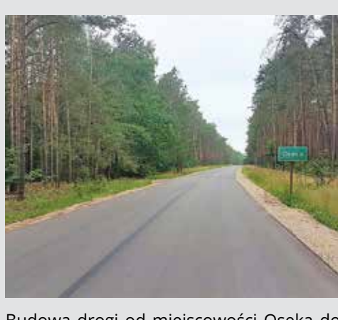
Budowa drogi od miejscowości Osęka do granicy powiatu, DP 4328W, gmina Strachówka. Koszt 989 052 zł.
