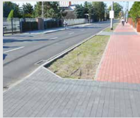
Przebudowa drogi powiatowej na odcinku przejazd PKP w Duczakach do ronda w Zagościńcu. Koszt 5 921 266 zł.
