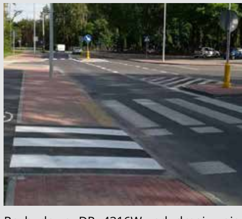
Rozbudowa DP 4316W, od drogi wojewódzkiej nr 634 do ronda w Majdanie, gmina Wołomin. Koszt 1 790 156 zł.
