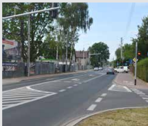
Przebudowa ciągu ulic Załuskiego, Zagańczyka, Mareckiej, Szerokiej w Kobylce. Koszt 4 497 287 zł.
